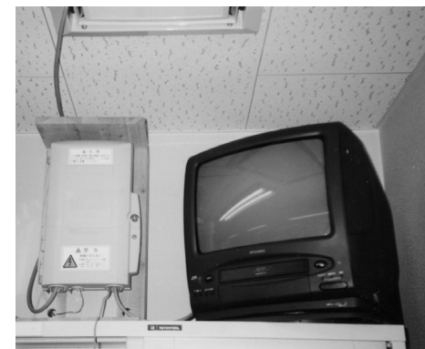
図1：実験協議会当時のIP電話アダプタ （テレビの横の箱がIPアダプタ（W230×H360×D140mm））
