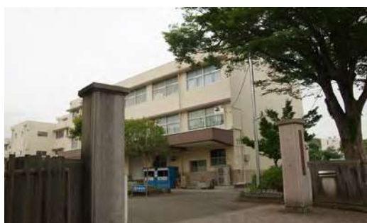
葵区公立小学校に設置したアンテナポール
