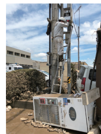
伝送路電源供給器の点検作業
