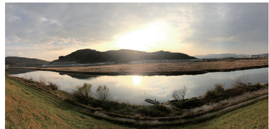
小田川合流点付け替え工事
