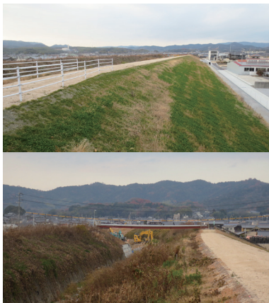
堤防の強化工事が進む真備町
